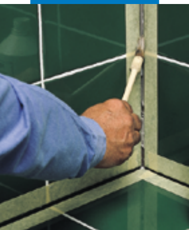
Gruntowanie boków szczeliny przy użyciu Primer FD
