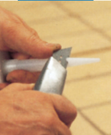
Przycinanie dyszy w zależności od przekroju szczeliny
