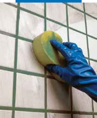
Czyszczenie i profilowanie fug na ścianie przy użyciu gąbki
