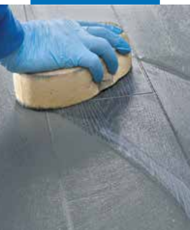
Przykład wykonania okładzin w łazience przy użyciu płytek gresowych; fugi na podłodze i ścianie wykonane zaprawą Ultracolor Plus
