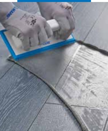
Aplikacja zaprawy Ultracolor Plus na podłodze przy użyciu gumowej pacy
