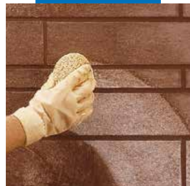
Czyszczenie i profilowanie fug gąbką
