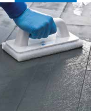
Czyszczenie i profilowanie fug pacą typu Scotch-Brite®
