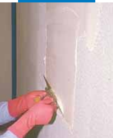
Nanoszenie zaprawy klejowej na Mapegum WPS
