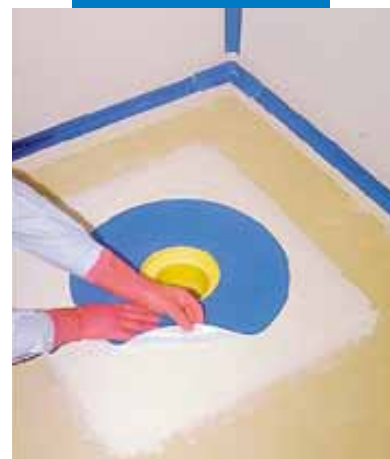
Montaż specjalnej taśmy Mapeband na Mapegum WPS
