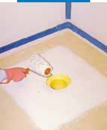
Nanoszenie izolacji Mapegum WPS w pobliżu ujścia rury odpływowej prysznicza
