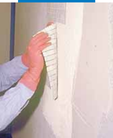
Montaż mozaiki szklanej
