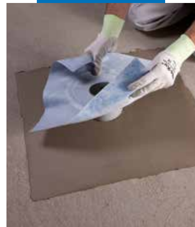
Montaż Drain Vertical na Mapelastic
