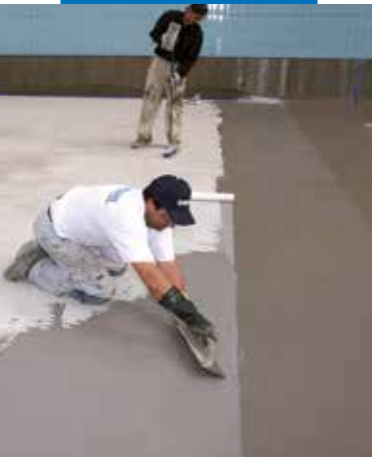
Hydroizolacja basenu z zastosowaniem Mapelastic
