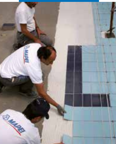
Montaż płytek ceramicznych na warstwie hydroizolacji Mapelastic
