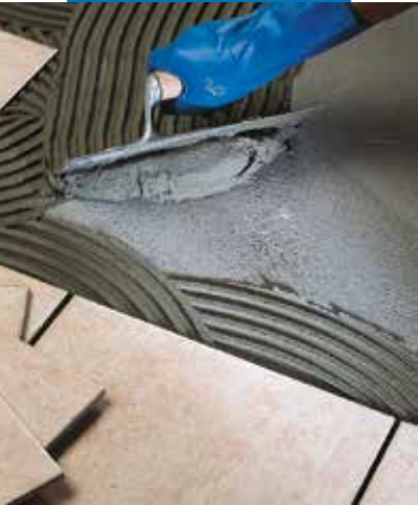
Montaż płytek typu monocottura na podłodze
